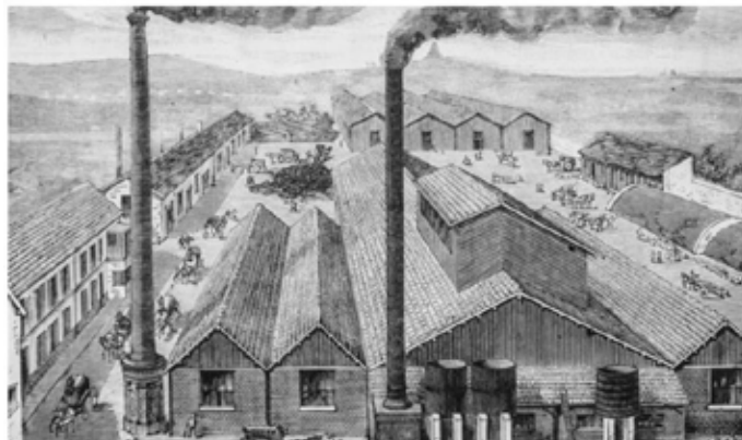
Usine urbaine de vidanges
